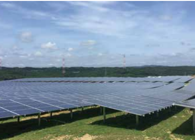
施工例（スチール製横置きタイプ）
