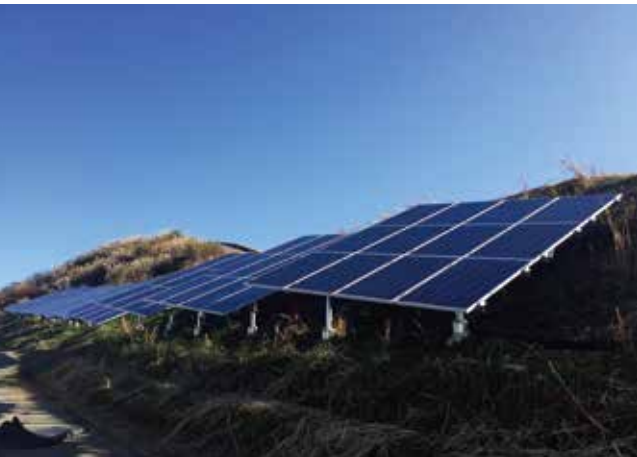
施工例（スチール製横置きタイプ）
