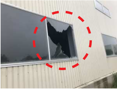
窓ガラスの破損
