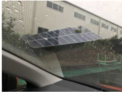
太陽光架台からパネルの外れ
