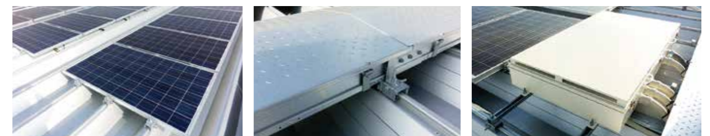
①太陽電池モジュール取り付け
