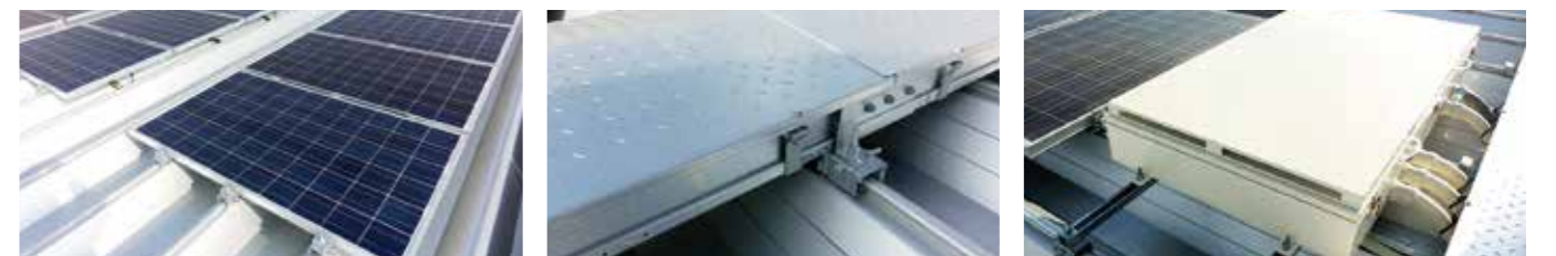
①太陽電池モジュール取り付け
