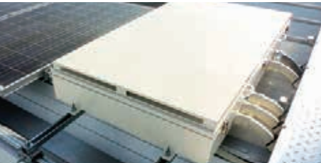
③平置きタイプの接続箱の取り付け
