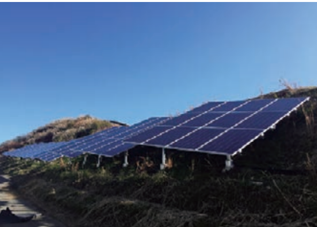
施工例(スチール製横置きタイプ)
