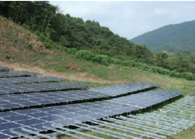
施工例(スチール製横置きタイプ)
