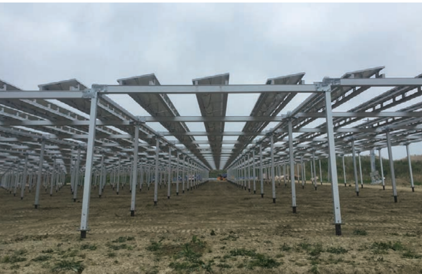
施工例(アルミ製横置きタイプ)
